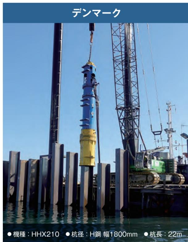
●機種：HHX210 ●杭径：H鋼 幅1800mm ●杭長：22m
