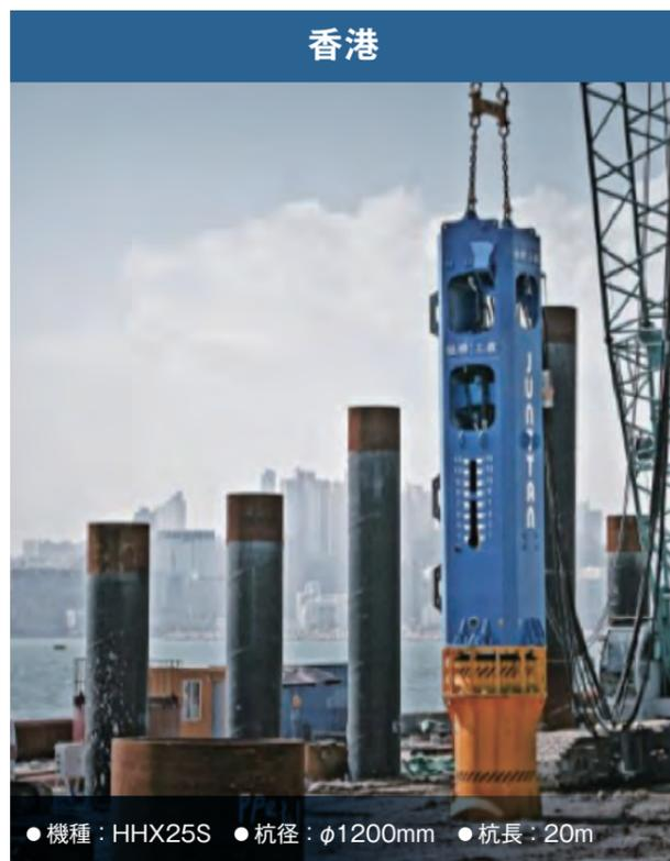
●機種：HHX25S ●杭径：φ1200mm ●杭長：20m
