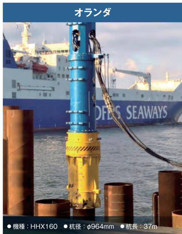
●機種：HHX160 ●杭径：φ964mm ●杭長：37m
