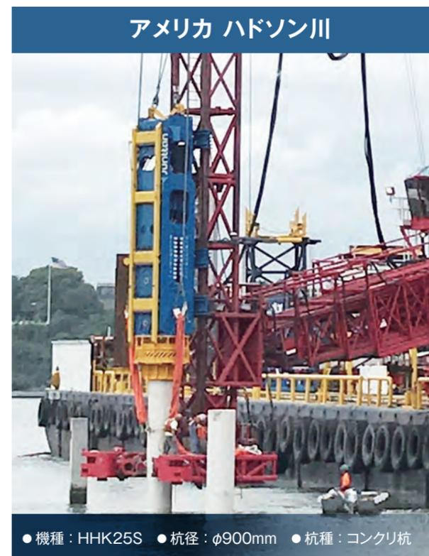
●機種：HHK25S ●杭径：φ900mm ●杭種：コンクリ杭
