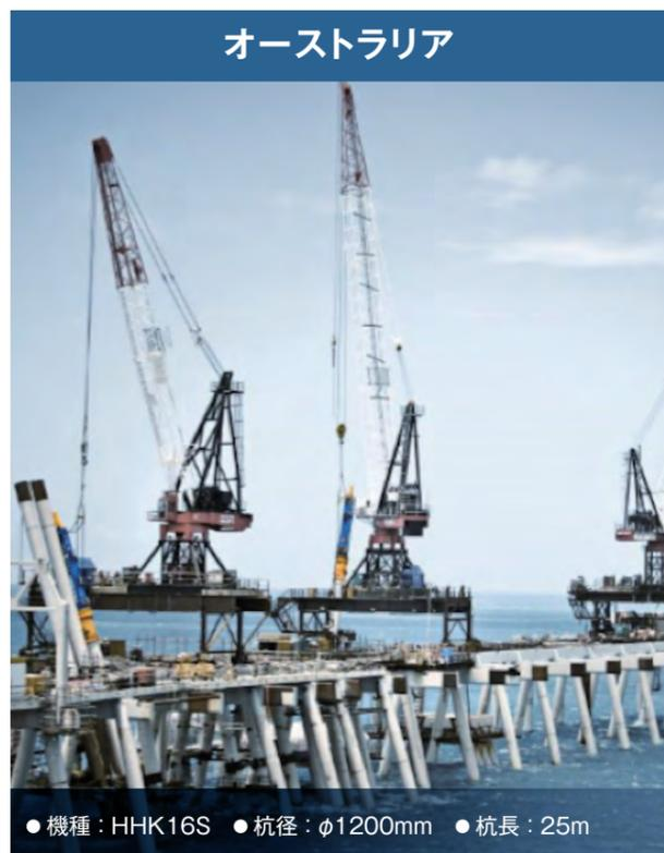
●機種：HHK16S ●杭径：φ1200mm ●杭長：25m
